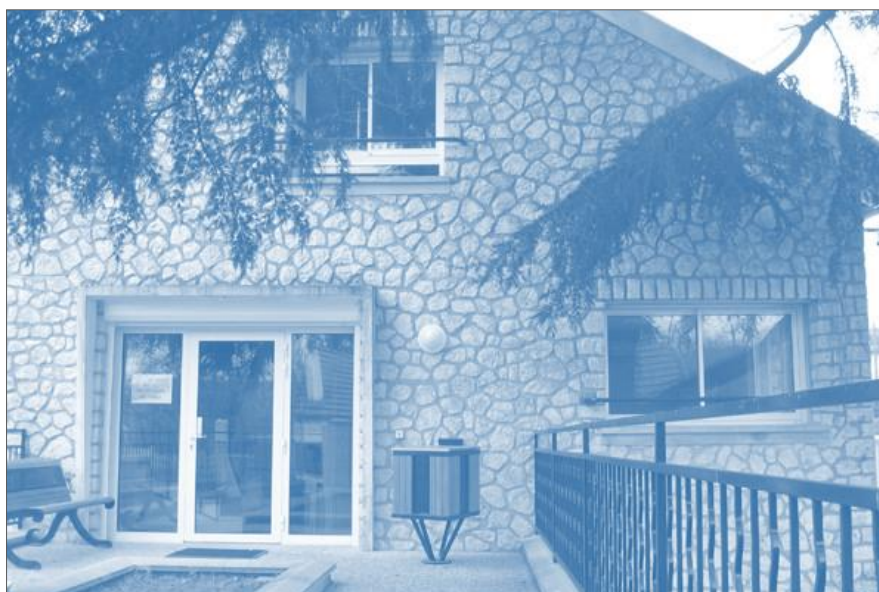
Bureau d'EPE77sud - Pôle famille - 5bis rue de la République, Veneux-les-Sablons 77250 Moret-Loing-et-Orvanne
